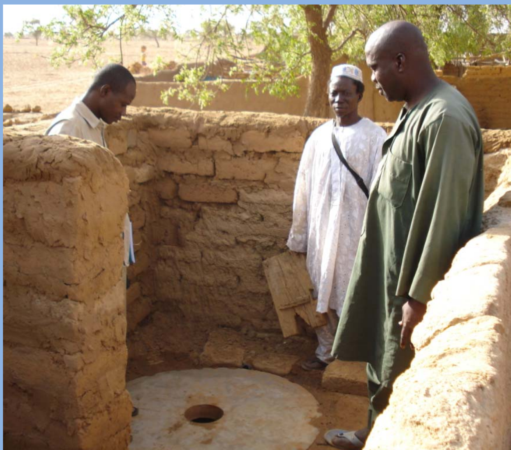
Latrine familiale, Commune de Bankass, Mali © Eau Vive
